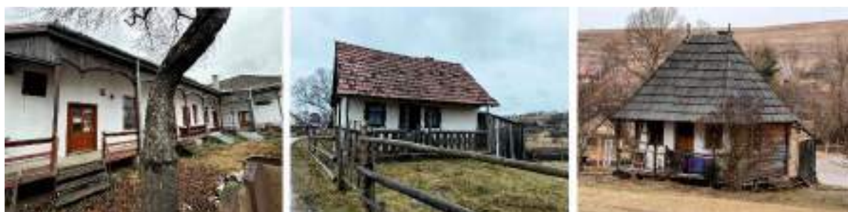
Figura 7 - Exemple de construcții tradiționale specifice ruralului din municipiul Miercurea Ciuc Sursa: Autori studiu istoric de fundamentare
