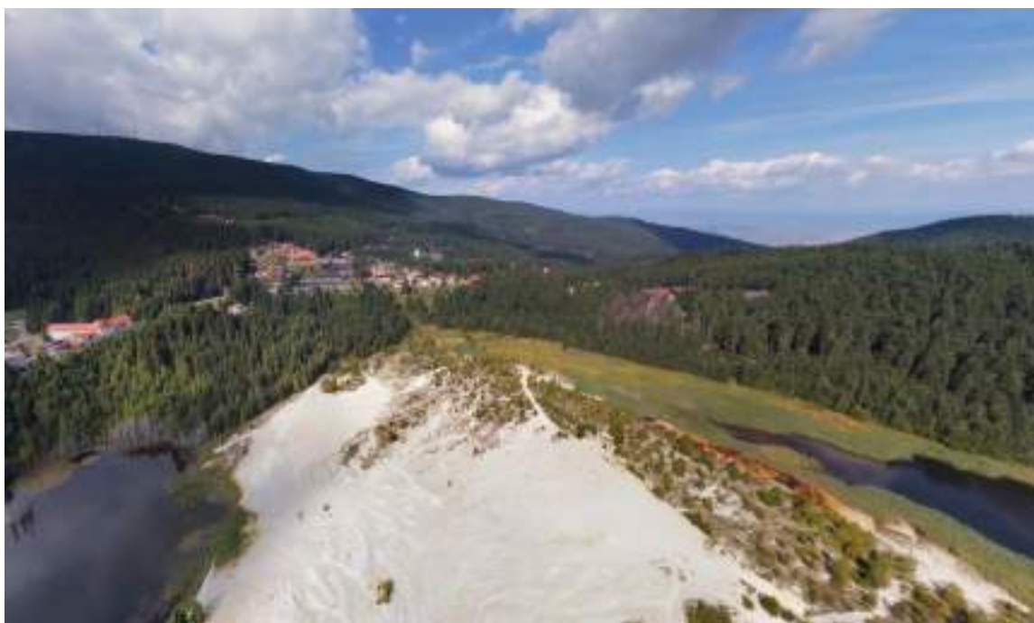
Figura 20 – Halda de steril din partea de sud a stațiunii cu iazul de decantare aferent Sursa: Google Maps, fotografie sferică, septembrie 2021
