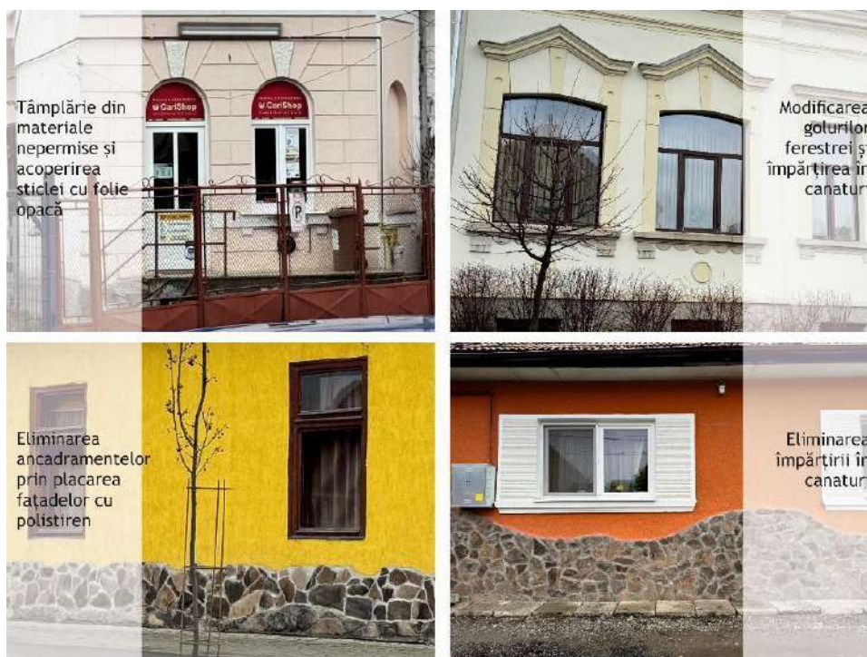
Figura 24 - Exemple negative de modificare a golurilor, a tâmplăriei ferestrelor și a raportului plin-gol, sursa: autorii Studiului Istoric General (Logic Plan SRL)
