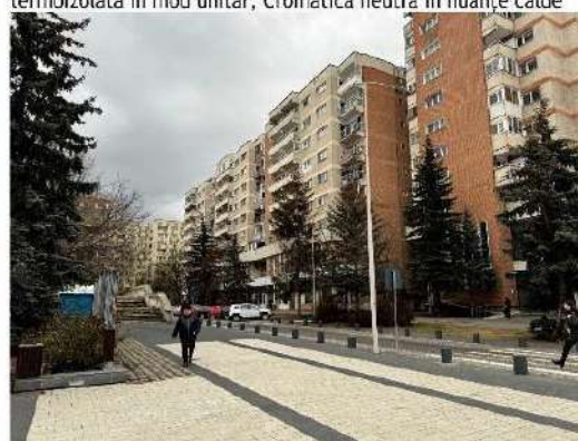
AȘA DA - Închiderea balcoanelor în mod unitar;
