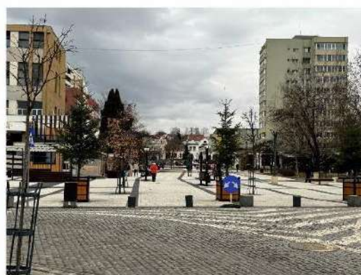
AȘA DA - Închiderea balcoanelor și termoizolarea clădirii în mod unitar;
