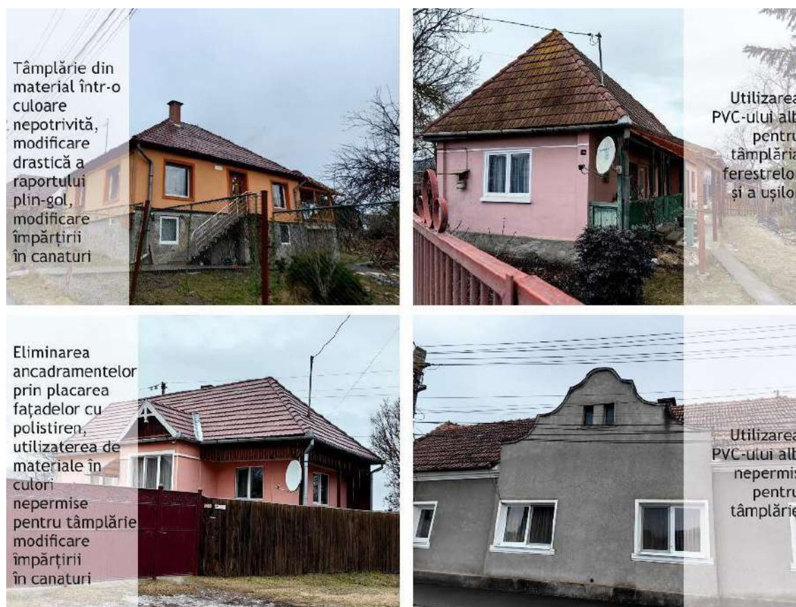
Figura 28 - Exemple negative de modificare a golurilor, a tâmplăriei ferestrelor și a raportului plin-gol, sursa: autorii Studiului Istoric General (Logic Plan SRL)
