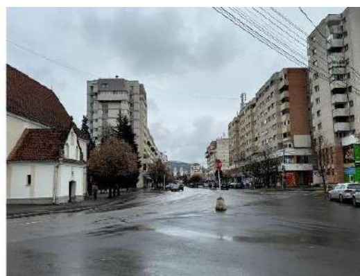
AȘA NU (dreapta) - Închiderea balcoanelor în mod neunitar, cu materiale distincte; Parter comercial cu signalistică agresivă AȘA DA (stânga) - Închiderea balcoanelor în mod unitar; Clădire termoizolată în mod unitar; Cromatică neutră în nuanțe calde
