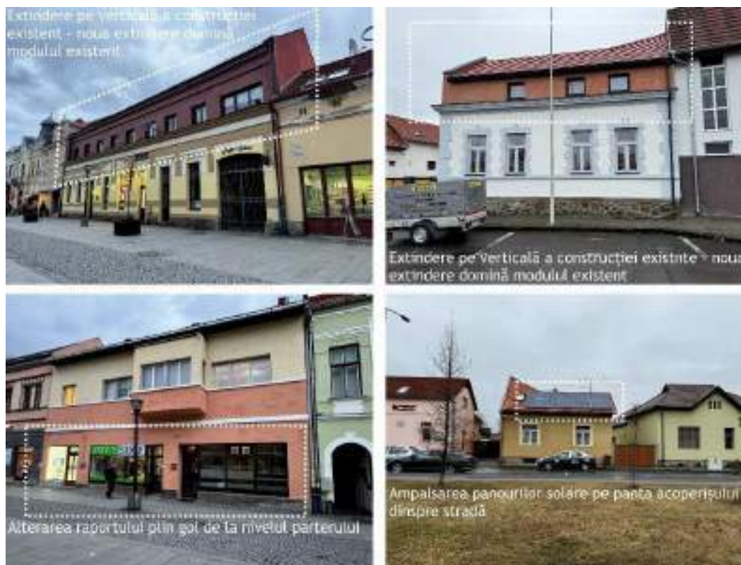
Figura 21 - Intervenții ce depreciază clădirile existente: extinderea pe înălțime a volumului și finisarea acestuia cu materiale ce depreciază volumul; ruperea raportului plin-gol de la parter, aspect ce poate pune în pericol și stabilitatea construcției; amplasa, sursa: autorii Studiului Istoric General (Logic Plan SRL)
